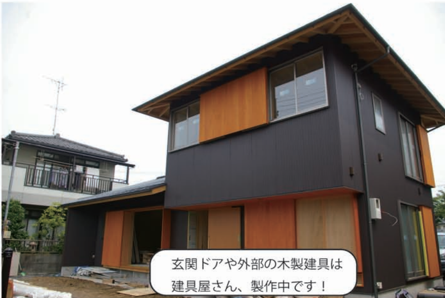
エンガワハウス外観写真
