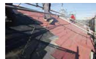
アスベスト入り着色セメント板を一枚一枚丁寧に剥し処分します。
