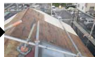
屋根面積の約2割を新しい合板(国産檜)の張替え。仕上は金属屋根材に葺き換えます。
